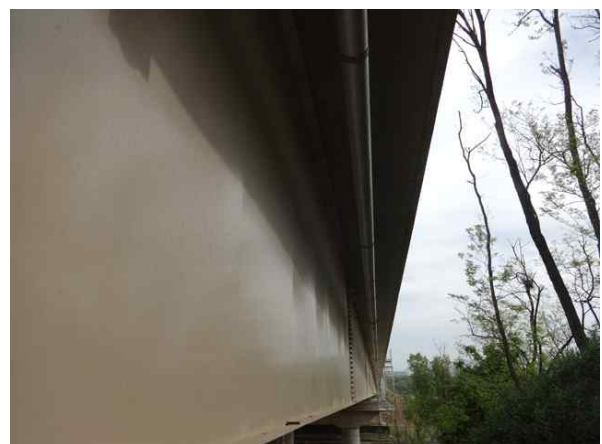
배수관 상태 양호
