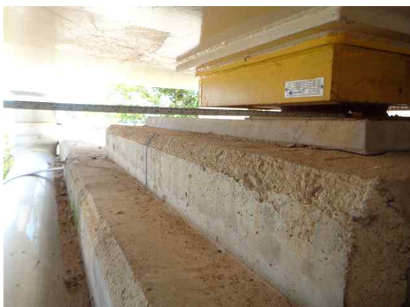
받침장치 연단거리 측정
