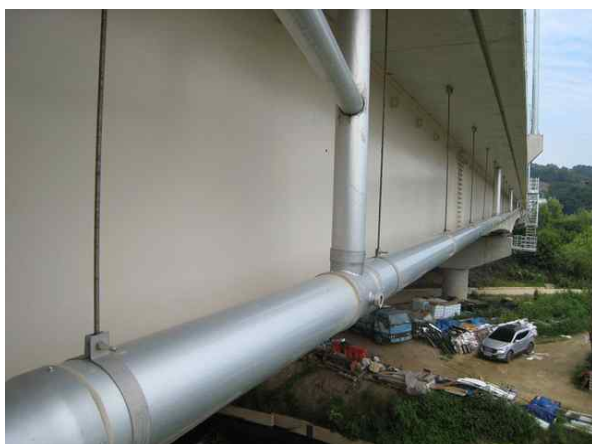
배수관 상태 양호
