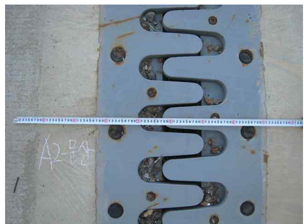
신축이음 이동량 측정
